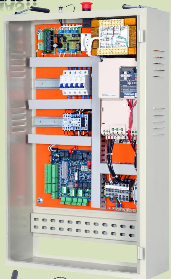
**Com Alças dobráveis, botão de EMERGÊNCIA e PLUG para caixa de inspeção**
